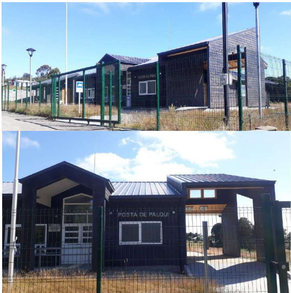
Fotografías de situación actual. La posta posee, además del recinto de salud, una casa para el residente, bodegas, sala de caldera, entre otros
