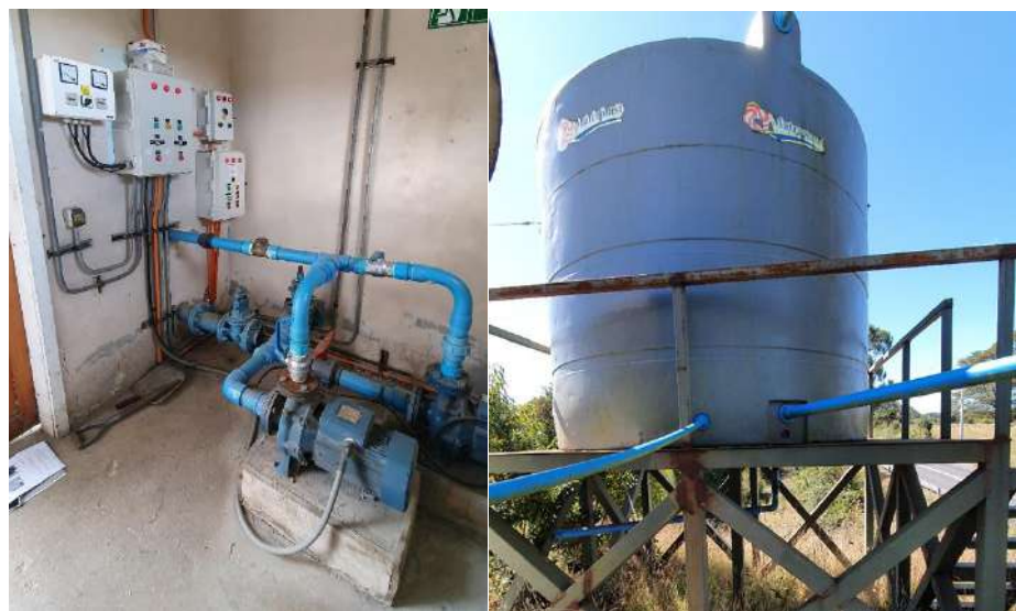
Fotografías de situación existente. El estanque actual será renovado por uno de mayor capacidad y sus equipos actuales se encuentran en deterioro, los cuales serán repuestos en su totalidad
